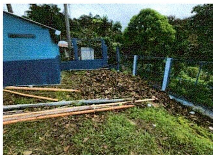
Foto 2: Mejoramiento, entechado lamina troquelada
