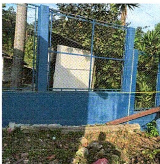
Foto1: Mejoramiento de Aula Tipo Portico
