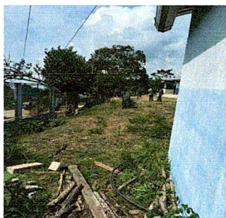
Foto 3: Mejoramiento de uso de losa alisado de aula.
